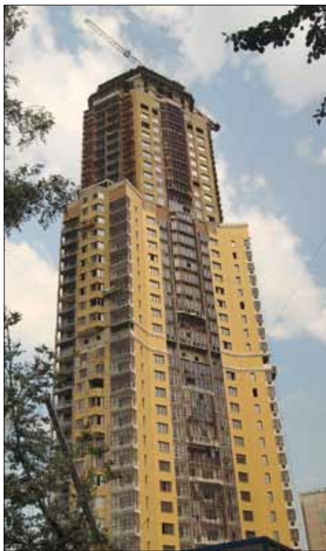
Рис. 1. Высотный жилой дом на ул. Дыбенко, 38 в процессе строительства
