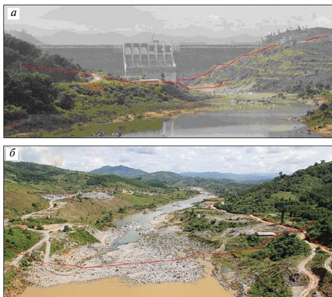
Рис. 3. Обследование состояния основания плотины Сон-Чань-2 со стороны нижнего бьефа с указанием линий профилей ММЗ: а – вблизи плотины; б – ниже по течению реки
