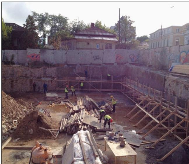
Рис. 6. Устройство подземной части здания
