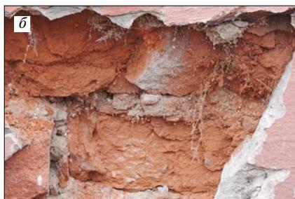
Рис. 4. Общий вид вскрытого участка № 3 в зоне цоколя (а); система мелких корней (б) на уровне пятого ряда разрушенной кладки
