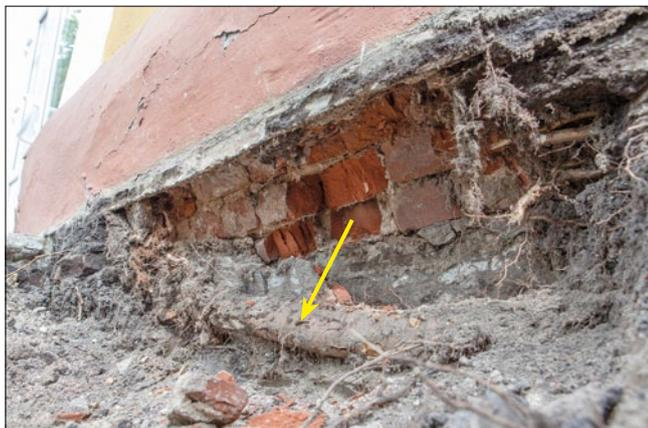
Рис. 2. Корни диаметром до 85 мм на участке вскрытия № 1
