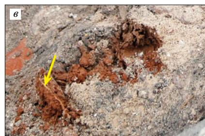
Рис. 3. Общий вид вскрытого участка № 2 (а); деструкция кладочного раствора системой мелких корней (б); полная деструкция кирпича и кладочного раствора (в); крупные корни показаны стрелками
