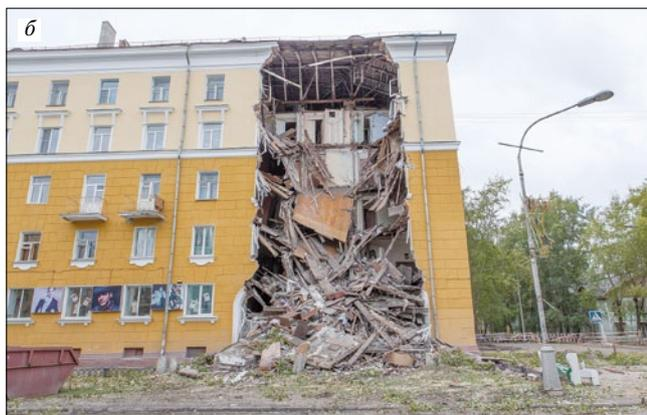
Рис. 1. Пятиэтажный кирпичный дом до (а) и после (б) аварии
