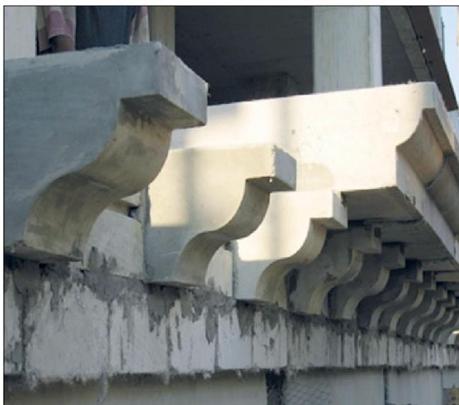
Рис. 5. Карнизные элементы офисного здания «Купеческий двор» на этапе строительства
