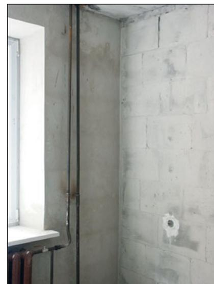
Рис. 4. Интерьер после проведения электротехнических работ, крепления отопительного оборудования и шпательования стен
