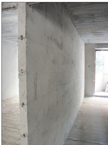
Рис. 3. Межкомнатная перегородка из блоков пазопропной формы после выполнения кладочных работ
