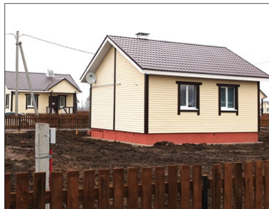
Компания «КНАУФ» активно участвовала в работах по строительству жилья после страшных пожаров 2010 г. Благодаря использованию высококачественной теплоизоляции и листовых материалов темпы строительства удалось существенно увеличить
