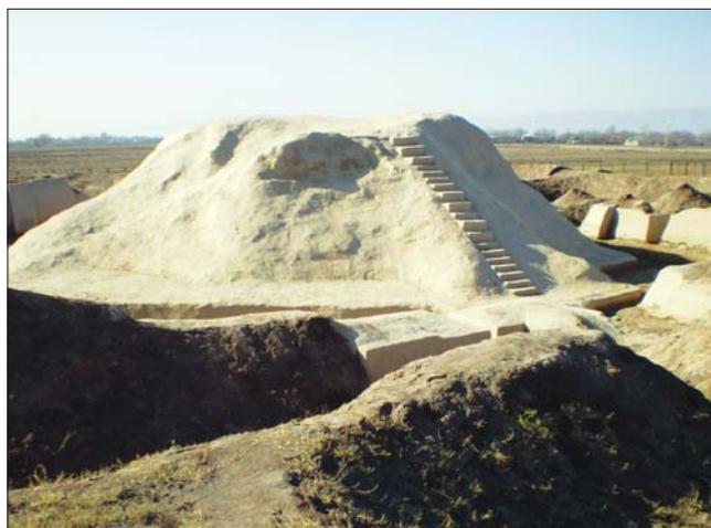
Рис. 2. Современная консервация руин глиняных стен
