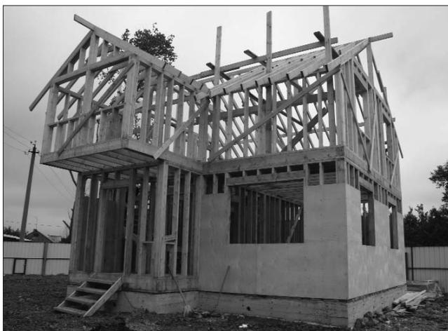
Рис. 2. Обшивка каркаса дома
