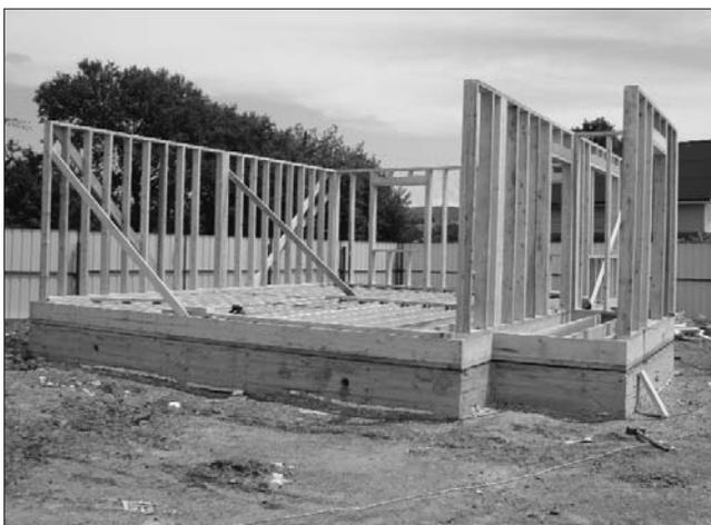
Рис. 1. Сооружение каркаса дома
