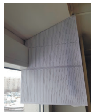
Рис. 3. Бумажный лист, установленный в верхней части окна Fig. 3. The paper sheet installed at the top of the window
