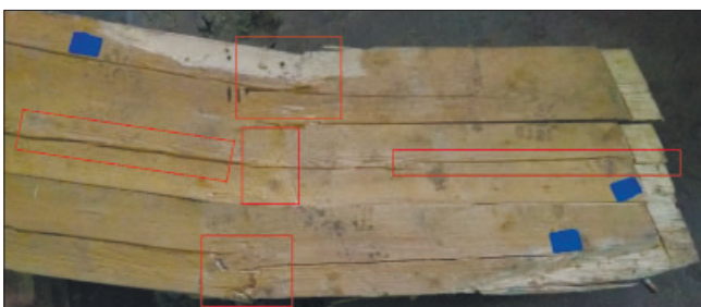
Рис. 13. Обследование конструкции после разрушения
