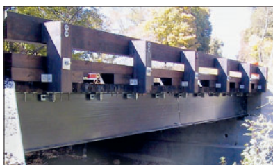
Рис. 5. Мост Департамента транспорта Вирджинии («Strongwell Corporation») Fig. 5. Virginia Department of Transportation Bridge («Strongwell Corporation»)
