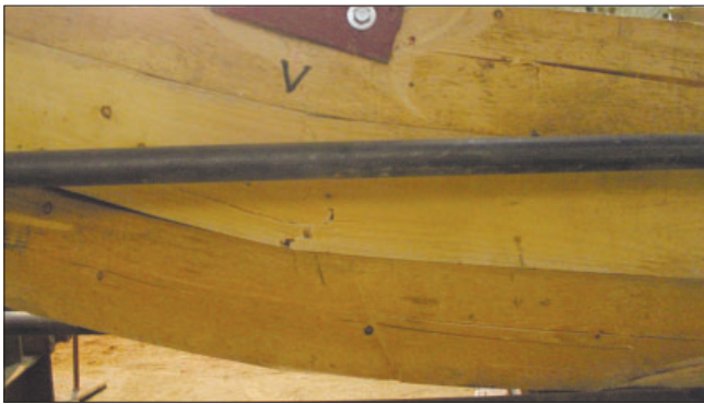
Рис. 12. Разрушение конструкции в пролетной части по нижнему и среднему брусам
