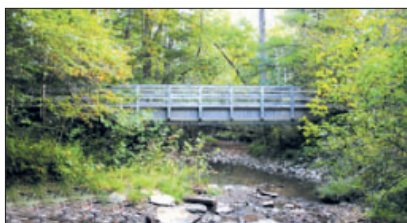
Рис. 2. Гибридный мост в округе Бат, штат Кентукки (США) с гибридным гетероволок- нистым армированием элементов конструк- ции сооружения («Strongwell Corporation»)
