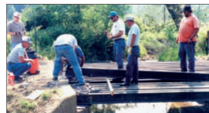
Рис. 3. Мост Томс-Крик, Блэксбург («Strongwell Corporation»)
