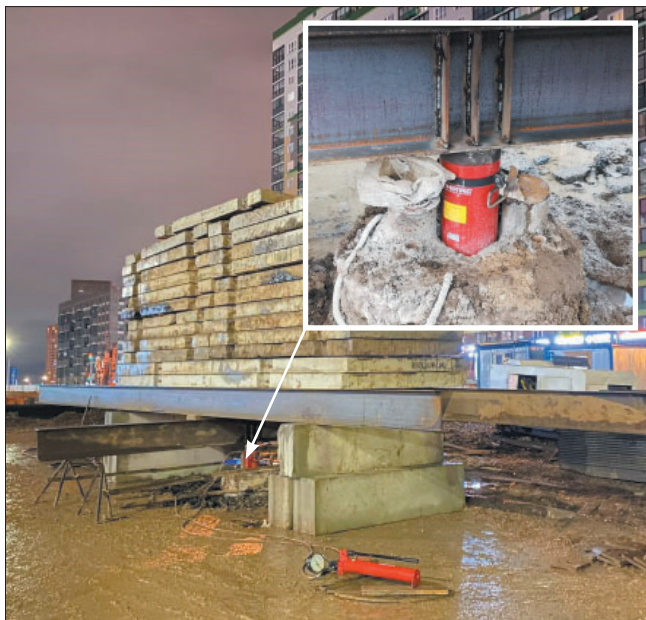
Рис. 4. Испытательный стенд. Общий вид Fig. 4. General view of the test stand
