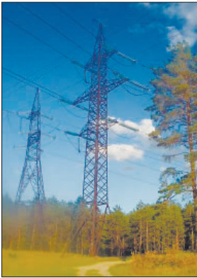
Рис. 1. Общий вид анкерно-угловой опоры ВЛ 220 кВ Fig. 1. General view of the anchor-corner support of 220 kV overhead line
