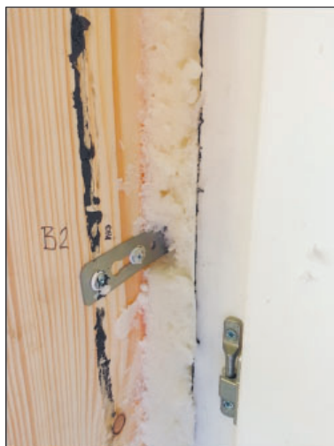
Рис. 7. Общий вид анкерных пластин в составе узла сопряжения оконного блока
