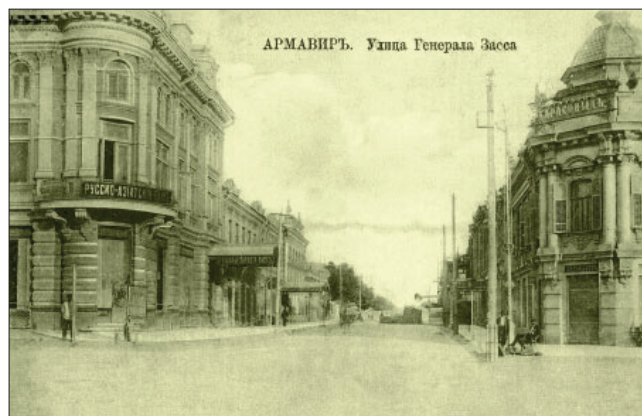
Рис. 1. Армавир, ул. им. генерала Засса. Вид от Николаевского проспекта к ул. Лорис-Меликовской. Справа расположен дом известных армянских купцов Тарасовых. 1913 г.
