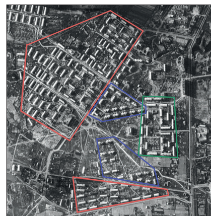
Рис. 6. Застройка поселка Завода им. Сталина на Варшавском ш. (Москва). Аэрофотосъемка 1942 г. Красным выделены коридорные жилые дома облегченных конструкций, синим – блокированные двухквартирные дома, зеленым – капитальные квартирные двухэтажные дома
