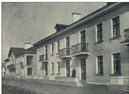
Рис. 7. Капитальные малоэтажные жилые дома автозавода им. Сталина (частично утрачены)
