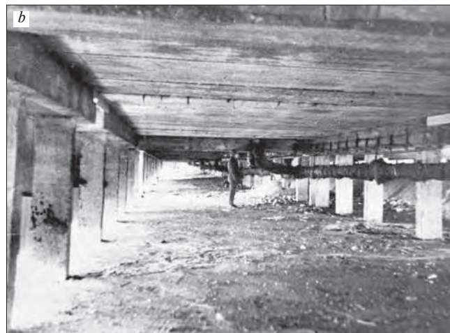
Рис. 5. Пример устройства свайного фундамента на вечномерзлых грунтах (а) и разрушения оголовков свай в зоне примыкания к рандбалке (б)
