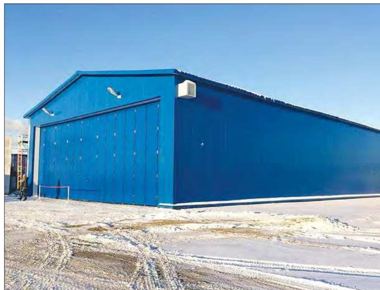
Рис. 2. Здание склада (заимствовано из общедоступных ресурсов)
