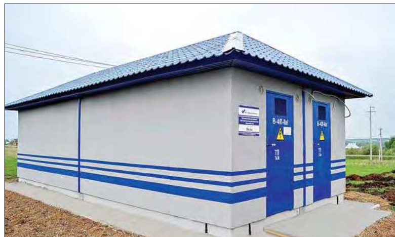
Рис. 1. Здание трансформаторной подстанции (заимствовано из общедоступных ресурсов)
