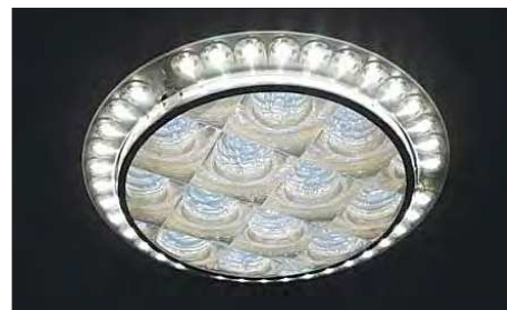
Рис. 8. Гибридная осветительная система «LED+«Solarspot»» (диаметр световодных труб 375 мм)
