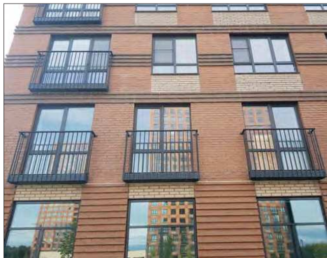
Пример использования крупноформатных окон в зданиях массовой жилищной застройки Example of the use of large-format windows in residential buildings
