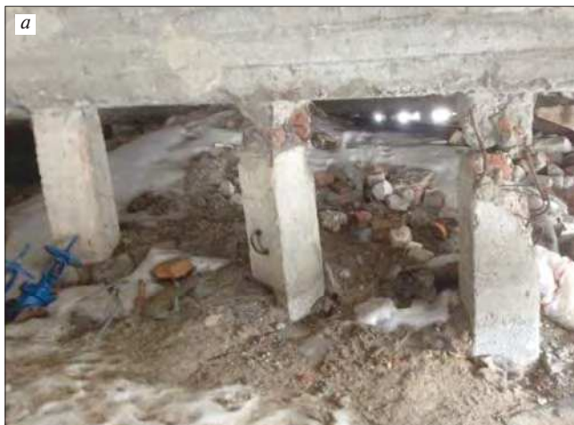
Рис. 5. Пример устройства свайного фундамента на вечномерзлых грунтах (а) и разрушения оголовков свай в зоне примыкания к рандбалке (б)
