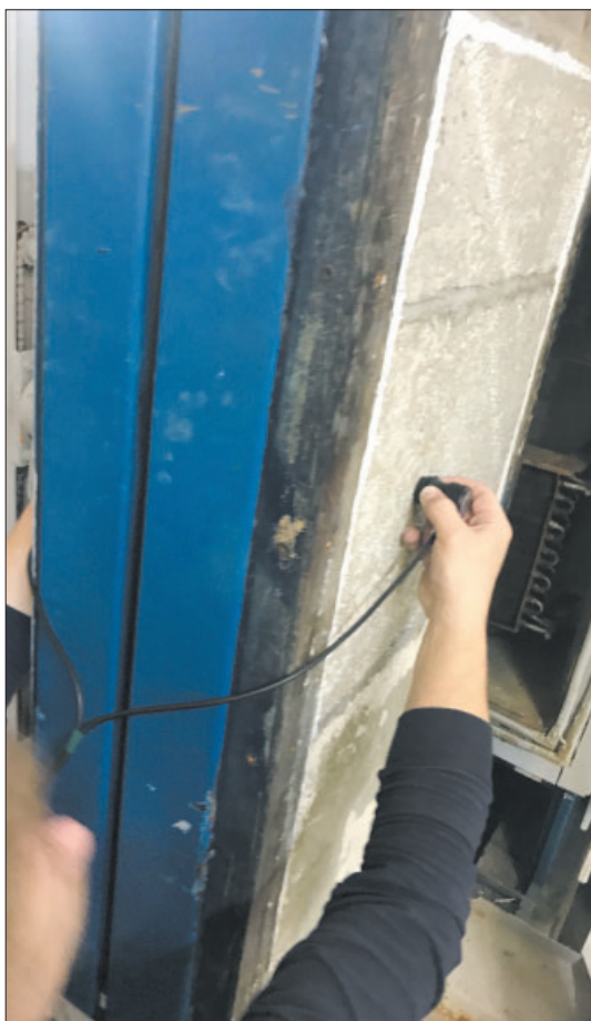
Рис. 4. Проведение сквозного прозвучивания фрагмента кладки из полистиролбетона ультразвуковым прибором Пульсар 2.2
