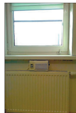
Рис. 12. Монтаж клапанов приточной вентиляции с очисткой воздуха в помещениях
