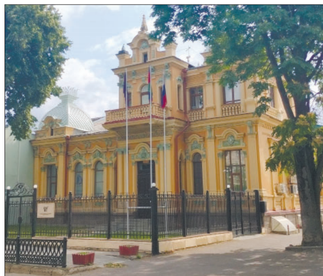
Рис. 3. Особняк В.К. Рубежанского. Фасад по ул. Коммунаров, начало XXI в. Фото автора
