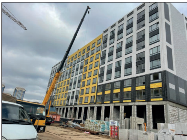
Рис. 8. Монтаж жилых домов с применением конструкций с широким шагом несущих стен (шаг 7,2 м, толщина плиты 160 мм) Fig. 8. Installation of a residential buildings using structures with wide spacing of load-bearing walls (spacing 7.2 m, slab thickness 160 mm)
