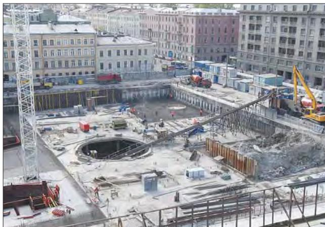
**Рис. 14.** Производство работ методом top-down на строительстве второй сцены Мариинского театра
