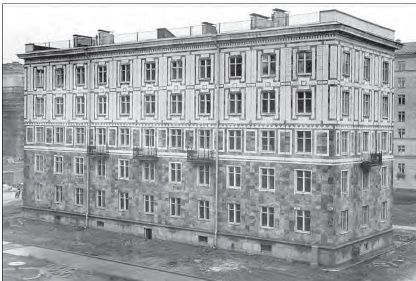
Рис. 1. Первый крупнопанельный экспериментальный жилой дом (серия 1-506э)
