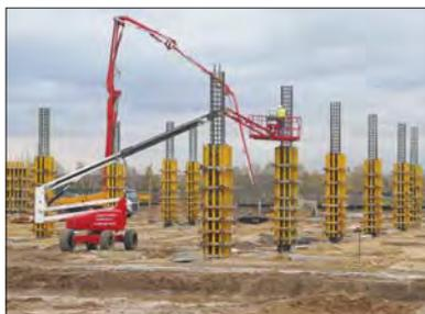
Рис. 4. Монтаж монолитных колонн на строительной площадке
