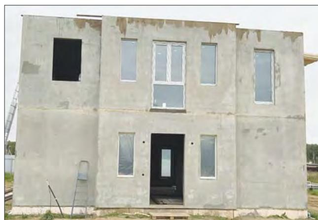
Рис. 2. Эркерная фасадная панель
