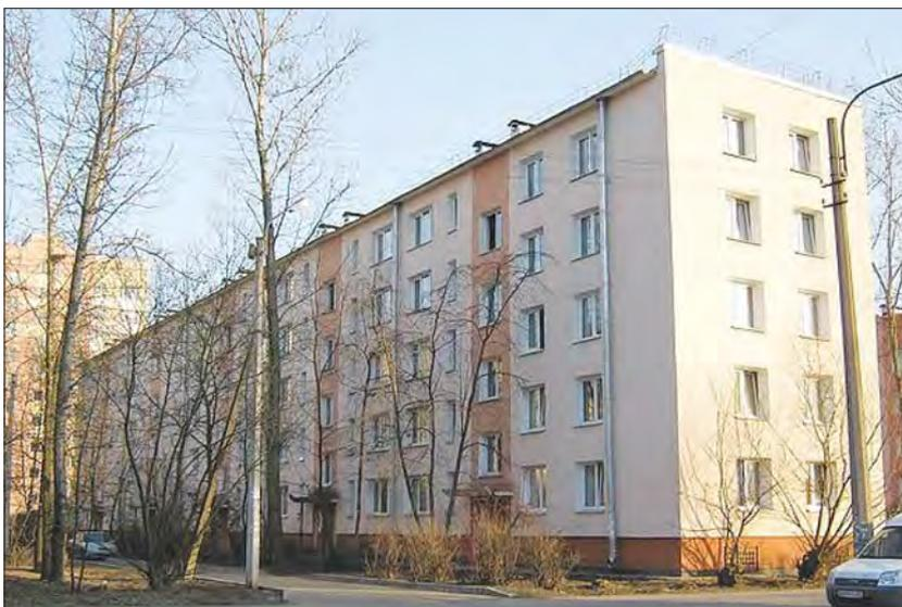
Рис. 9. Крупнопанельные дома серии ГИ
