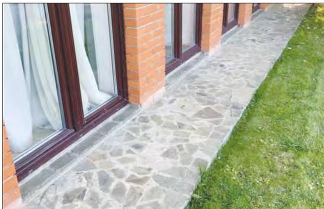
Рис. 6. Фрагмент отмостки дома
