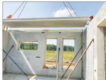
Рис. 7. Фрагмент монтажа панельно-монолитного дома
