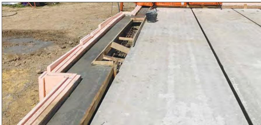
Рис. 5. Фрагмент возведения фундамента панельно-монолитного дома
