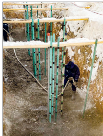
Рис. 3. Проливка грунта обратной засыпки водой Fig. 3. Spilling backfill soil with water
