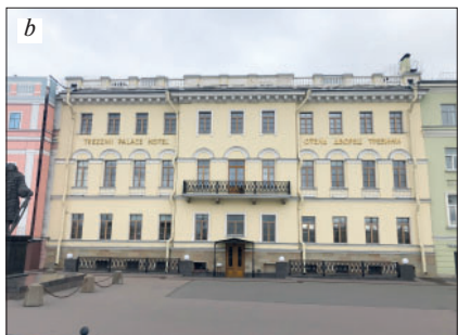
Рис. 9. Жилой дом «на погребах» («образцовый дом для именитых»), авт. М.Г. Земцов: а – проект, 1739 г.; б – дом Треззини на Университетской наб., 21 (1723–1736 гг., в 1830-е гг. надстроен третий этаж); возможно, проект здания выполнен самим Д. Треззини, однако непосредственно постройкой занимался М.Г. Земцов
