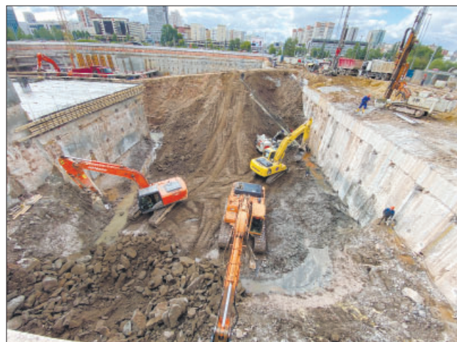
Рис. 1. Общий вид площадки строительства Fig. 1. General view of the construction site
