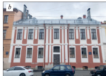
Рис. 8. «Образцовый дом для именитых», автор Ж.-Б. Леблон: а – гравюра А.И. Ростовцева по чертежу Ж.-Б. Леблона (подпись внизу: «При- сланный от его царского величества чертеж, по которому всем на реку строящимся строить таковым образом...») [7]; б – дом Подворья Александро-Невской лавры, 1720–1726 гг., 7-я линия ВО, 12
