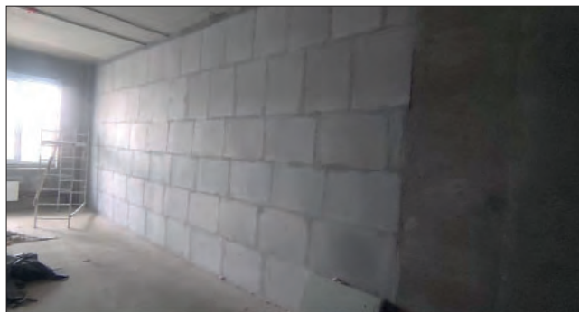
Рис. 1. Перегородка из пазогребневых блоков Fig. 1. Partition of tongue-and-groove blocks
