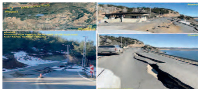
Рис. 8. Оползни и поверхностные трещины на дорогах (METU-Центр инженерных исследований землетрясений) Fig. 8. Landslides and Surface Cracks on Roads (METU-Earthquake Engineering Research Center)
