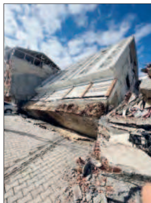
Рис. 15. Опрокидывание из-за разжижения грунта и недостаточной детализации армирования швов Fig. 15. Overturning due to soil liquefaction and insufficient detailing of the seam reinforcement
