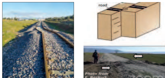
Рис. 10. Смещение дорог и железнодорожных путей (METU-Центр инженерных исследований землетрясений) Fig. 10. Displacement of roads and railways (METU-Earthquake Engineering Research Center)
