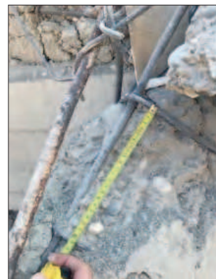
Рис. 15. Опрокидывание из-за разжижения грунта и недостаточной детализации армирования швов Fig. 15. Overturning due to soil liquefaction and insufficient detailing of the seam reinforcement
