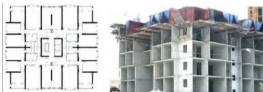
Рис. 17. Здания туннельной формы Fig. 17. Tunnel shaped buildings
