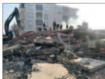
Рис. 15. Опрокидывание из-за разжижения грунта и недостаточной детализации армирования швов Fig. 15. Overturning due to soil liquefaction and insufficient detailing of the seam reinforcement
