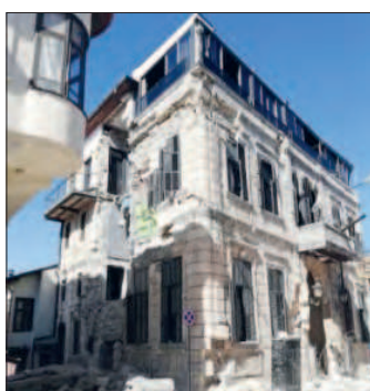
Рис. 19. Повреждения каменных конструкций
