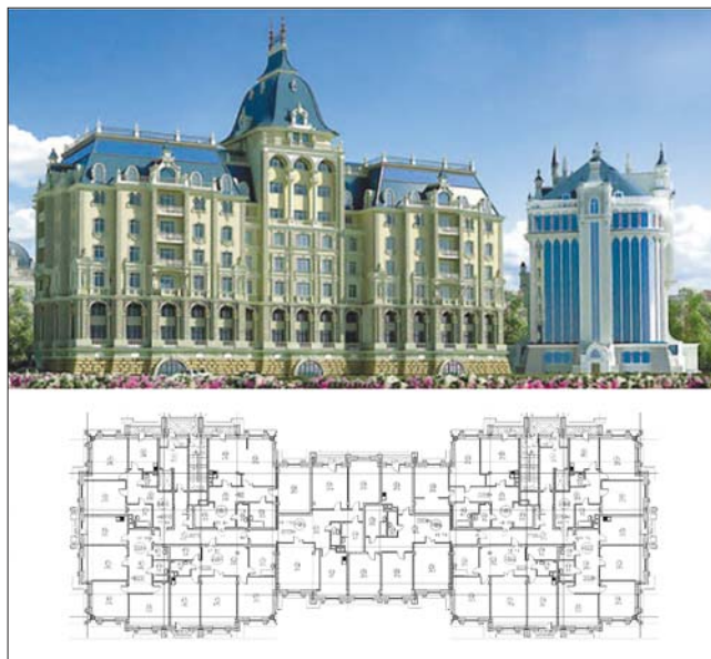
Рис. 4. Жилой комплекс «Ренессанс» (Казань, ул. Касаткина). Арх. А.Л. Горник, 2009 г. Fig. 4. Residential complex «Renaissance» (Kazan, Kasatkina st.). Arch. A.L. Gornik, 2009 ( http://antica.co/ru/mass-media/topbuilder/ )
