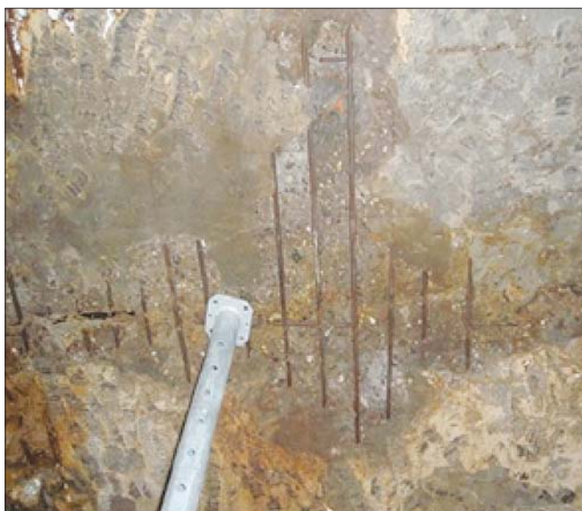
Рис. 2. Разрушение строительных конструкций от воздействия нефтепродуктов Fig. 2. Destruction of building structures due to the impact of petroleum products
