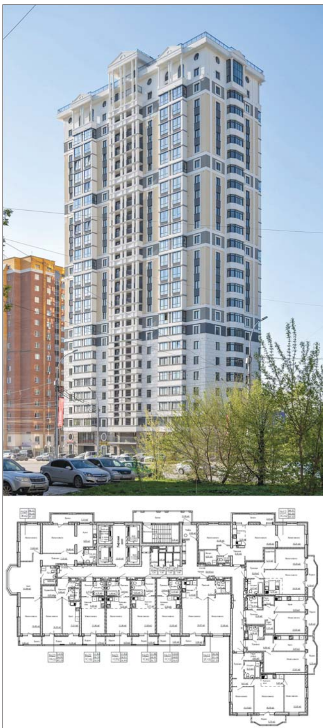
Рис. 6. Жилой комплекс «Дом на Березовой роще» (Новосибирск, ул. Кошурникова). Арх. И.В. Штурбабин, И.А. Штурбабина, А.В. Паршукова, М.Н. Никитушкина, 2017–2019 гг.
