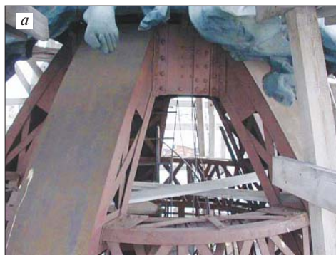
Рис. 9. Верхняя (а) и нижняя (б) части металлического каркаса купола
