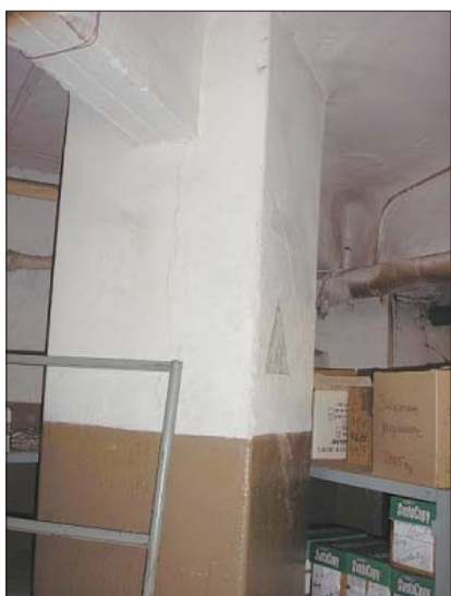
Рис. 18. Характерные вертикальные трещины в кирпичной облицовке колонн в подвале (по результатам обследования института «Геореконструкция», 2007)
