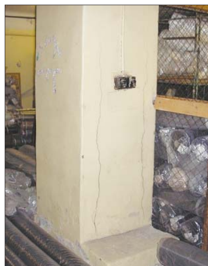
Рис. 18. Характерные вертикальные трещины в кирпичной облицовке колонн в подвале (по результатам обследования института «Геореконструкция», 2007)
