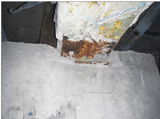
Рис. 19. Характерные вертикальные трещины раскрытием 0,3–0,4 мм по бетонной обойме колонн, выполненной по проекту усиления 2007 г. (фото 2014 г.)
