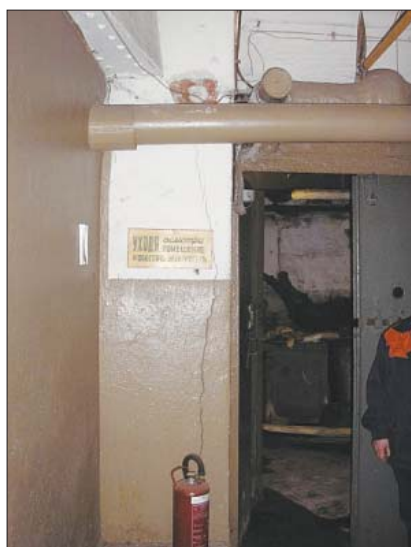
Рис. 18. Характерные вертикальные трещины в кирпичной облицовке колонн в подвале (по результатам обследования института «Геореконструкция», 2007)
