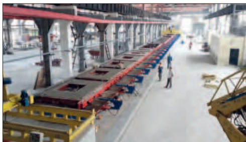
Рис. 5. Автоматизированная технологическая линия с универсальным стендом с откидными и раздвижными гидравлическими бортами, с адресной подачей бетона, вибробетоноукладчиком, с заглаживающей машиной для выпуска НС. ОАО «Хойникский завод ЖБИ» (г. Хойники, Республика Беларусь), 2015 г. Fig. 5. Automated production line with a universal stand with folding and sliding hydraulic sides, with targeted concrete supply, a vibrating concrete paver, with a smoothing machine for the release of OW. JSC «Khoyniksky Reinforced Concrete Plant» (Khoyniki, Republic of Belarus), 2015
