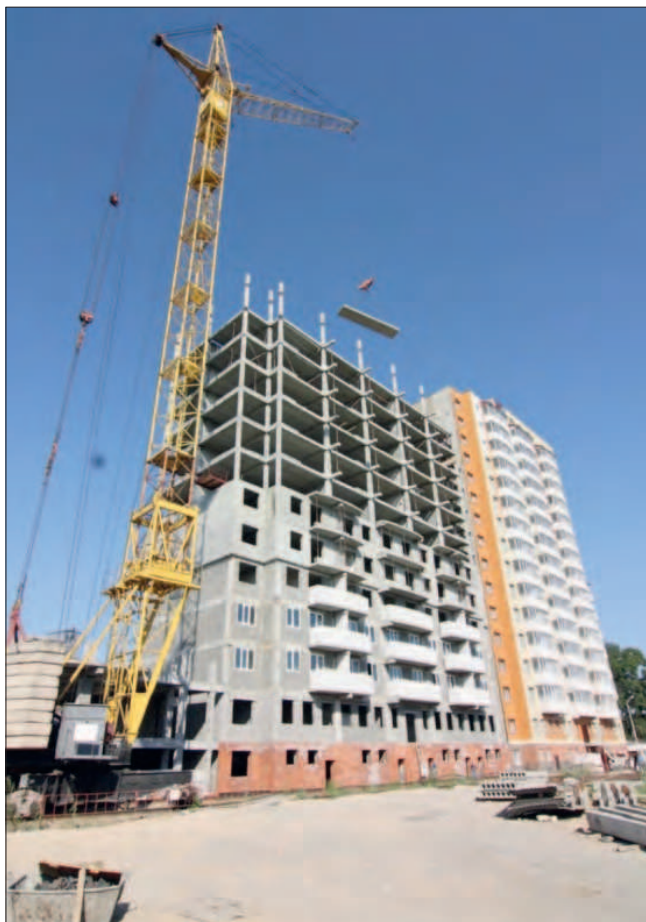
Рис. 4. Строительство 15-этажного жилого дома с применением СМК с пустотным настилом и трехслойной наружной стеной (НС) нового типа, г. Чебоксары
