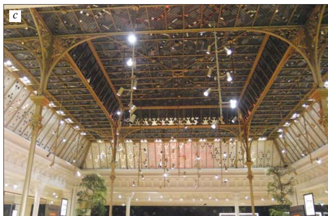
Рис. 2. Универсальный магазин Ле-Бон-Марше. Париж. Арх. Буало, инж. Г. Эйфель. Современное состояние: а – интерьер атриума; б – главный вход; с – интерьер. Фото автора
