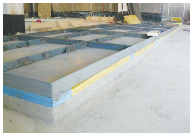
Рис. 6. Реализованная конструкция плавающего пола в техническом помещении Fig. 6. Implemented floating floor design in the technical room
