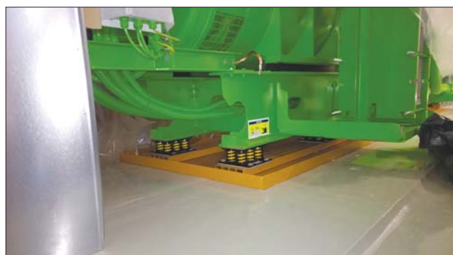
Рис. 3. Опоры под высокоточное медицинское оборудование Fig. 3. Supports for high-precision medical equipment
