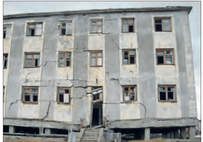
Рис. 1. Разрушение многоквартирного дома ( https://goarctic.ru/politics/chem-grozit-poteplenie-stroitelstvu-na-merzlotе/ ) Fig. 1. Destruction of an apartment building ( https://goarctic.ru/politics/chem-grozit-poteplenie-stroitelstvu-na-merzlotе/ )
