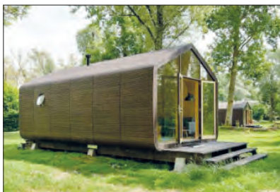
Рис. 3. Жилой дом с наружными стенами из водонепроницаемого картона. Источник: https://www.archdaily.com/889151/modular-eco-housing-pushing-boundaries-with-cardboard
