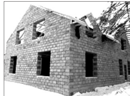
Рис. 4. Блочное строительство коттеджа
