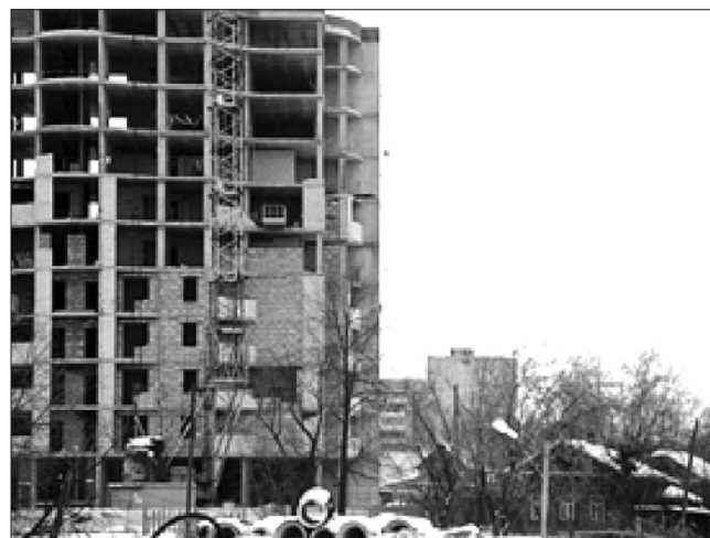
Рис. 6. Строительство многоэтажного здания
