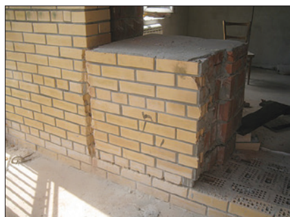
Рис. 1. Отбор образцов фрагментов каменной кладки из подоконной части наружных стен жилого дома
