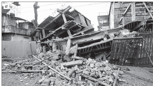
Рис. 1. Разрушения железобетонных каркасных зданий средней этажности при действии сильных землетрясений: а – обрушение в результате Имфхальского землетрясения (Manipur, Индия; 04.01.2016; M=6,7 ; h=55 км). В здании образовался механизм пластического деформирования, характерный для зданий с гибким нижним этажом ( http://indianexpress.com/article/india/india-news-india/earthquake-measuring-6-8-magnitude-strikes-india/ ); б – результат Элязгыского землетрясения (Elazig, Турция; 24.01.2020; M=6,7 ; h=12 км; t=40 с). В здании реализовался механизм пластического деформирования «сильные ригели – слабые колонны» с последующим образованием гибкого нижнего этажа ( https://tsn.ua/ru/svit/kolichestvo-pogibshih-ot-zemletryaseniya-v-turcii-snova-vyroslo-razrusheny-desyatki-zdaniy-1480812.html?g=article&m=401671908 )
