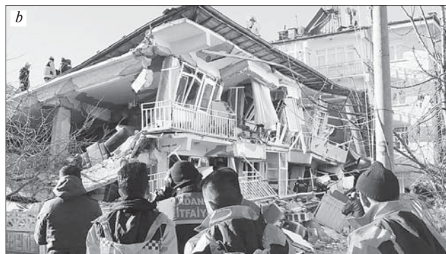
Рис. 1. Разрушения железобетонных каркасных зданий средней этажности при действии сильных землетрясений: а – обрушение в результате Имфхальского землетрясения (Manipur, Индия; 04.01.2016; M=6,7 ; h=55 км). В здании образовался механизм пластического деформирования, характерный для зданий с гибким нижним этажом ( http://indianexpress.com/article/india/india-news-india/earthquake-measuring-6-8-magnitude-strikes-india/ ); б – результат Элязгыского землетрясения (Elazig, Турция; 24.01.2020; M=6,7 ; h=12 км; t=40 с). В здании реализовался механизм пластического деформирования «сильные ригели – слабые колонны» с последующим образованием гибкого нижнего этажа ( https://tsn.ua/ru/svit/kolichestvo-pogibshih-ot-zemletryaseniya-v-turcii-snova-vyroslo-razrusheny-desyatki-zdaniy-1480812.html?g=article&m=401671908 )
