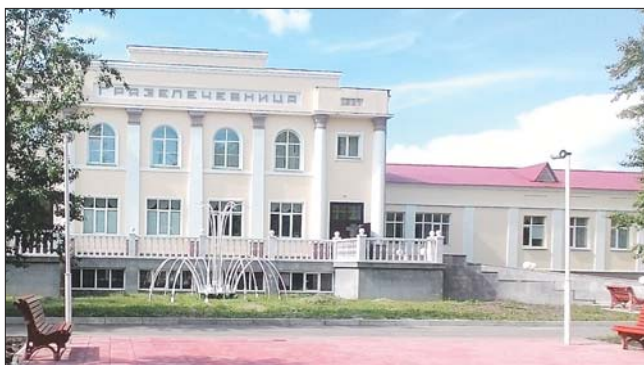
Рис. 11. Главный фасад здания водогрязелечебницы после ремонта и реконструкции Fig. 11. The main facade of the building of the balneary after repair and reconstruction
