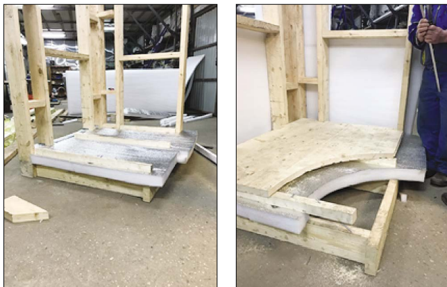
Рис. 2. Система утепления деревянного пола
