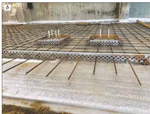
Рис. 4. Установка арматурных каркасов (a) и разделительных элементов (b)
