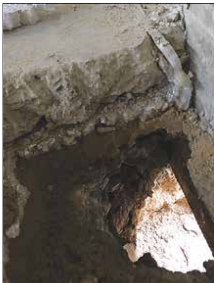
Рис. 7. Мониторинг состояния изоляционного слоя плавающего пола Fig. 7. Monitoring the condition of the insulation layer of the floating floor
