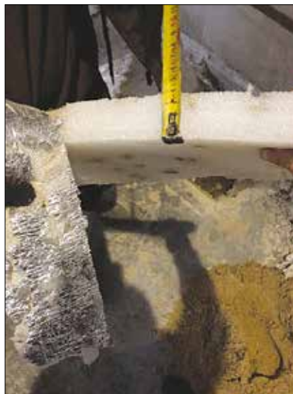
Рис. 7. Мониторинг состояния изоляционного слоя плавающего пола Fig. 7. Monitoring the condition of the insulation layer of the floating floor
