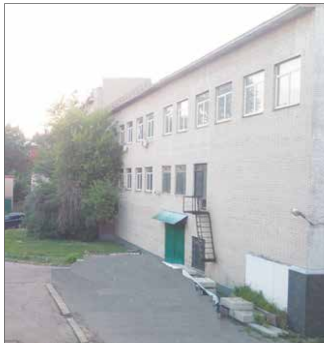
Рис. 3. Исследуемая стена на фасаде здания Fig. 3. Location of the wall under study on the facade of the building
