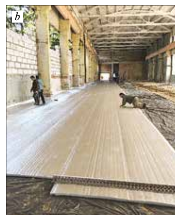
Рис. 3. Укладка рулонов пенополиэтилена (a) и их сварка горячим воздухом (b)
