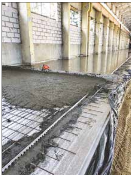
Рис. 5. Укладка бетона Fig. 5. Concrete laying
