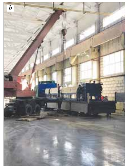
Рис. 6. Готовый пол (a) и монтаж технологического оборудования с помощью крана (b) Fig. 6. Finished floor (a) and installation of technological equipment using a crane (b)
