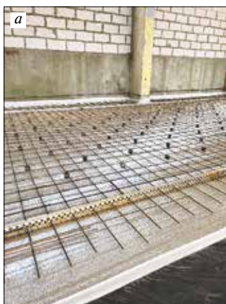
Рис. 4. Установка арматурных каркасов (a) и разделительных элементов (b)
