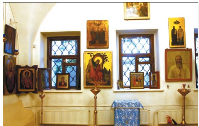
Рис. 1. Северная стена храма с расположенными под иконами отопительными приборами
