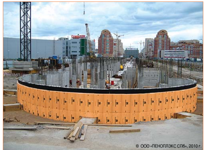
Пример использования плит ПЕНОПЛЭКС® для теплоизоляции фундамента здания
