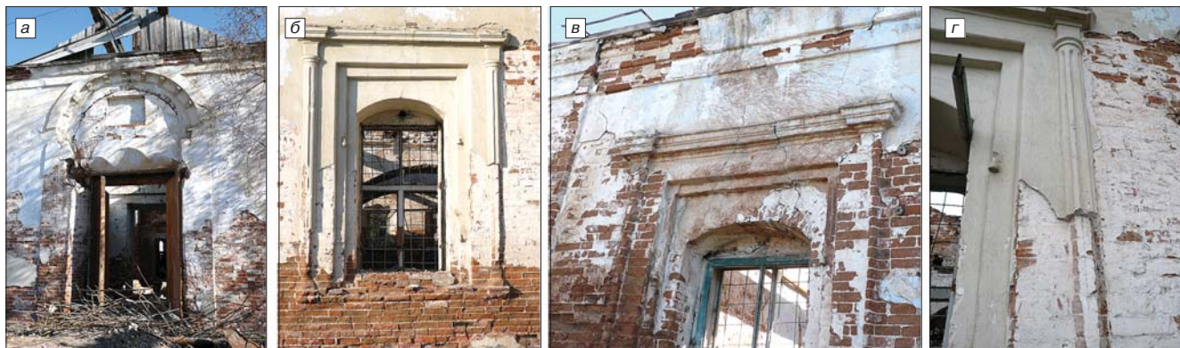
Рис. 3. Декоративные детали XIX в.: а – обрамление западного входа; б – наличник окна; в – детали окна и карниза; г – фрагмент штукатурного наличника
