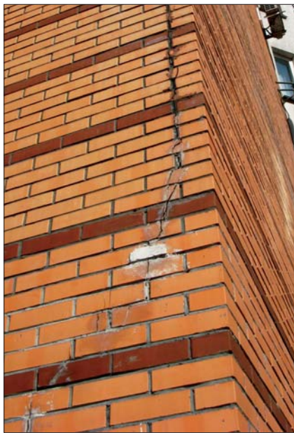
Рис. 3. Двухслойная наружная стена с внутренним слоем из крупноформатных керамических камней производства ЛСР с трещинами вследствие отсутствия в проекте вертикальных и горизонтальных деформационных швов
