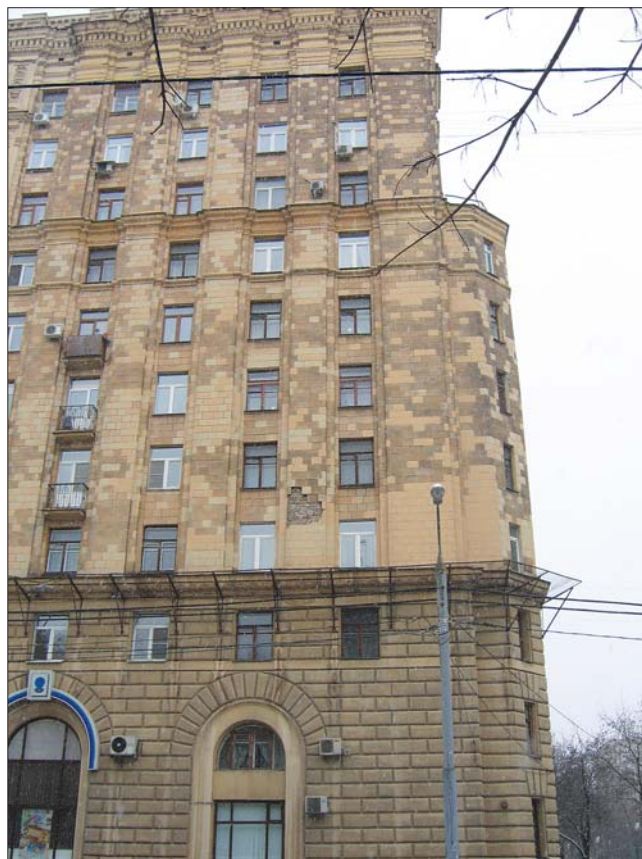
Рис. 3. Фрагменты фасадов зданий, облицованных керамическими плитами, построенных в Москве в 1955–1960 гг. (после капитального ремонта)
