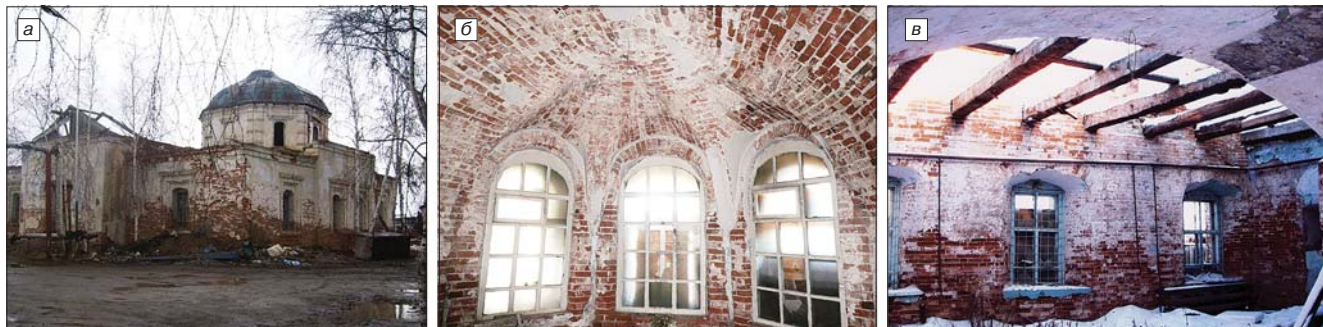
Рис. 4. Богородицкая церковь перед реставрацией: а – фото церкви 2007 г.; б – кирпичный свод апсиды XVIII в. с распалубками над окнами; в – северный придел XIX в. с деревянными балками перекрытия
