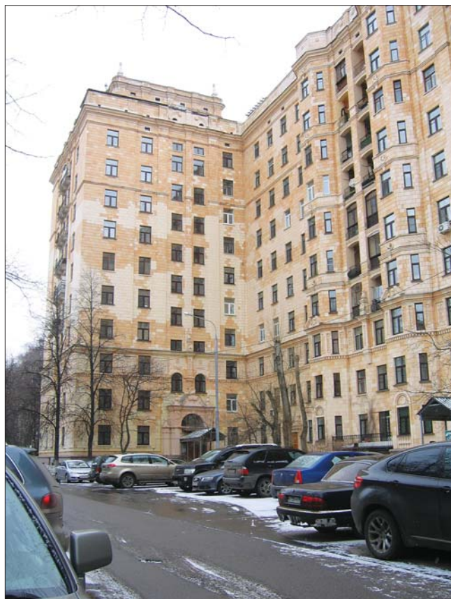
Рис. 3. Фрагменты фасадов зданий, облицованных керамическими плитами, построенных в Москве в 1955–1960 гг. (после капитального ремонта)
