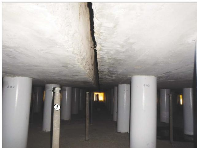
Рис. 9. Низ плиты ростверка в зоне деформационного шва: 1 – скважина СОУ
