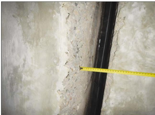
Рис. 8. Деформационный шов шириной 120 мм
