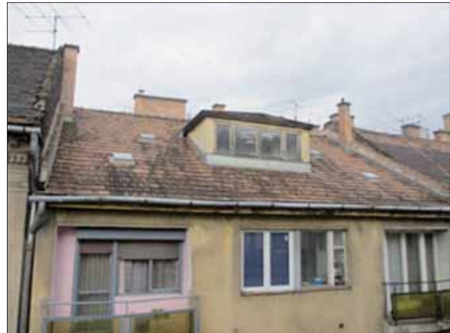
Рис. 3. Развитие диатомовых водорослей на черепичной кровле
