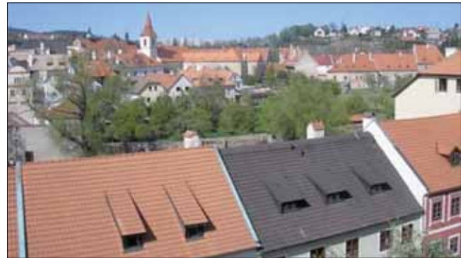
Рис. 1. Типичная кровля из керамической черепицы жилых и общественных зданий в городах Германии и Чехии
