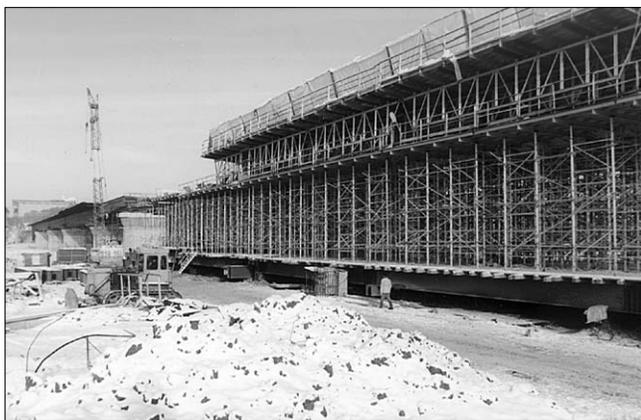
Рис. 1. Конструкция алюминиевой опалубки
