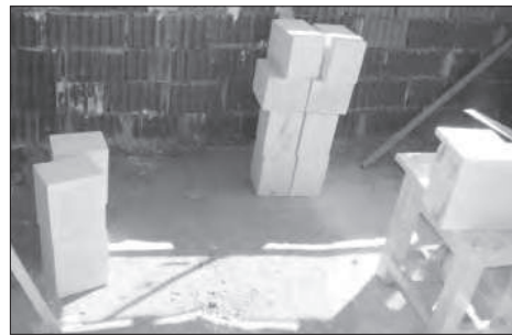
Рис. 1. Подготовка образцов-кубов и блоков из ячеистого бетона для изготовления фрагментов кладок, предназначенных для проведения испытаний на морозостойкость
