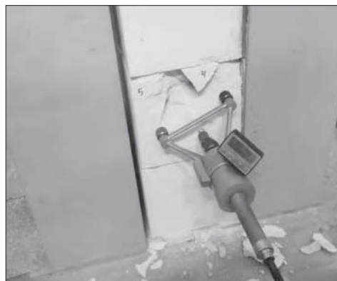
Рис. 3. Проведены испытания прочности на вырыв химических анкеров на контрольном образце фрагмента кладки и по завершении циклических воздействий Fig. 3. Tests of the pull-out strength of chemical anchors were carried out on a control sample of a masonry fragment and upon completion of cyclic impacts
