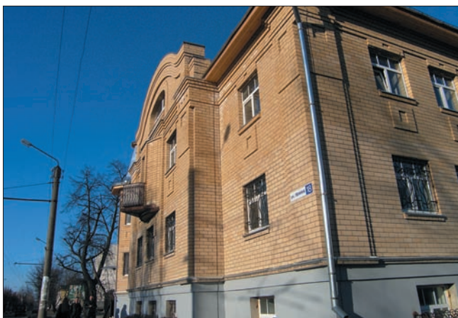
Здание из силикатного кирпича
