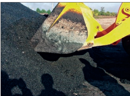
Рис. 4. Погрузка холодной асфальтобетонной смеси
