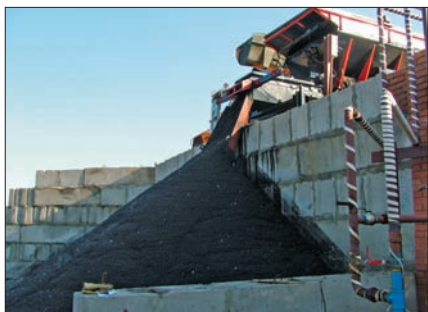
Рис. 3. Технологическая установка по получению холодного асфальтобетона на ГУП «Башкиравтодор»
