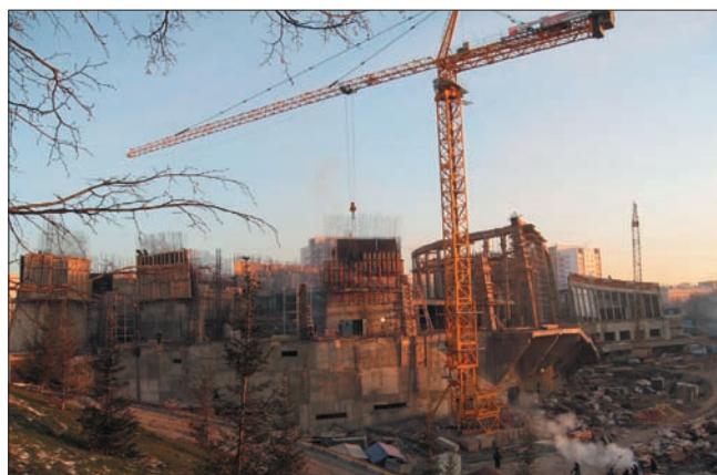
Строительство Дома дружбы народов Республики Башкортостан
