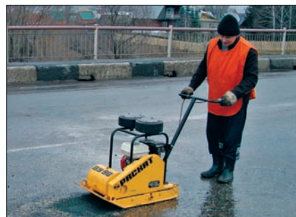
Рис. 5. Ямочный ремонт автодороги с применением холодной асфальтобетонной смеси
