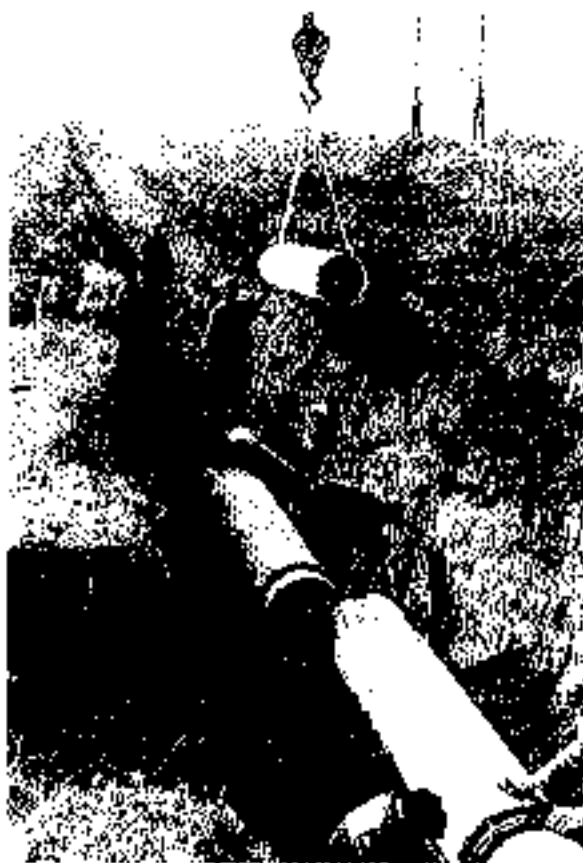
Рис. 1. Прокладка газопровода из асбестоцементных труб диаметром 456 мм с чугунными соединительными муфтами
