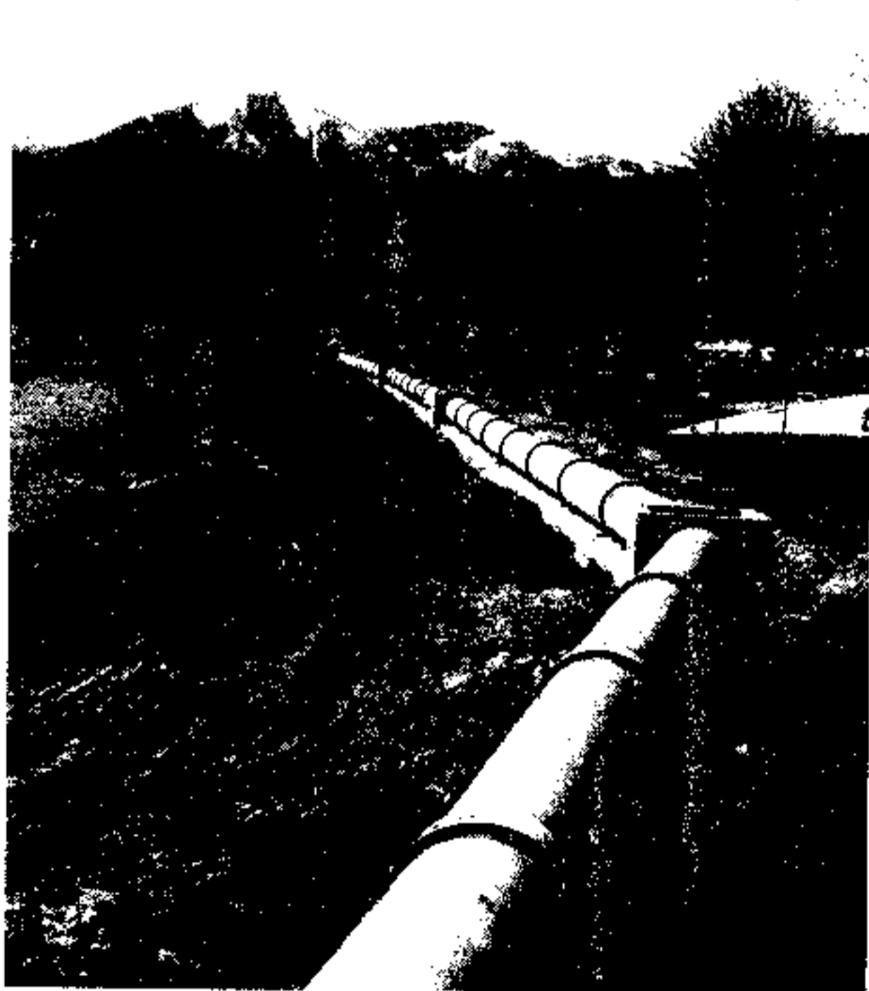
Пример применения асбестоцементных труб в сооружении трубопровода наземной прокладки
