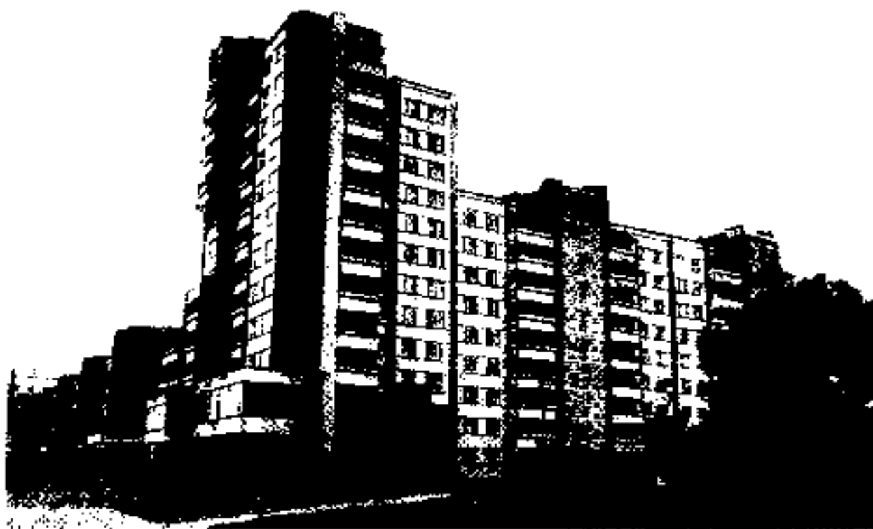
Жилой дом 5—9—12-этажный из кирпича и ячеистого бетона по ул. Горького в г. Гродно
