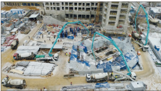
Рис. 6. Бетонирование распределительной балки-плиты Fig. 6. Distribution beam-slab concreting
