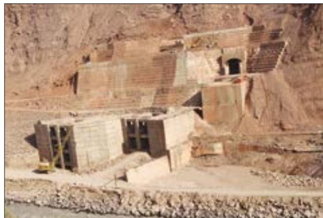
Рис. 2. Оголовки строительно-отводящих туннелей СТ-1 и СТ-2, подпорные стены и временный водоприемник Рогунской ГЭС. Данные объекты являются гидротехническими сооружениями подводного и переменного уровней воды
