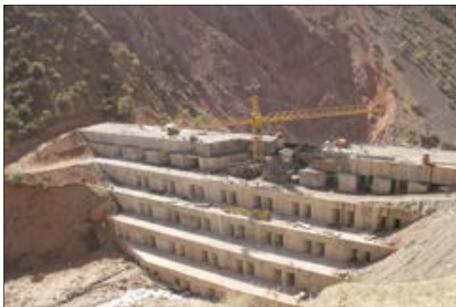
Рис. 1. Селезашчинская плотина «Сай Оби Шур» – одно из гидротехнических сооружений Рогунской ГЭС. Согласно проекту на ее возведение израсходовано 250 тыс. м 3 бетонной смеси
