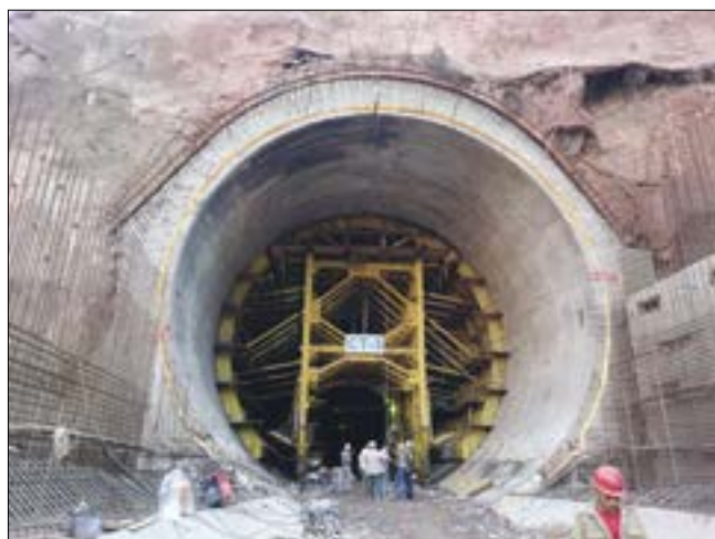
Рис. 6. Строительно-эксплуатационный туннель СТ-3 Рогунской ГЭС. Расположен на правом берегу гидроузла. Пропускная способность 3,5 тыс м 3 /с; протяженность 1750 м; внутренний диаметр 15 м. В составе бетона конструктивной отделки данного сооружения применена низкокальциевая зола-уноса
