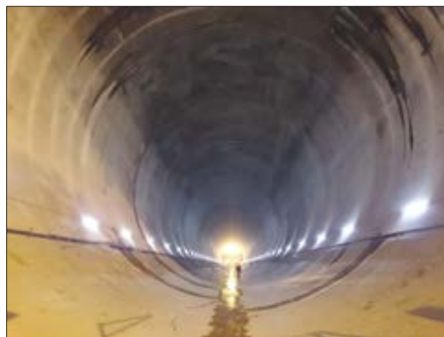
Рис. 6. Строительно-эксплуатационный туннель СТ-3 Рогунской ГЭС. Расположен на правом берегу гидроузла. Пропускная способность 3,5 тыс м 3 /с; протяженность 1750 м; внутренний диаметр 15 м. В составе бетона конструктивной отделки данного сооружения применена низкокальциевая зола-уноса
