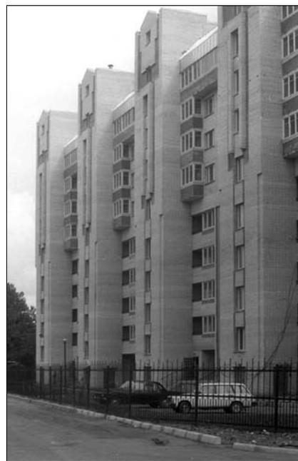
Рис. 1. АОЗТ «Ленстройтрест № 5» (Санкт-Петербург) надстроило четыре этажа, провело перепланировку квартир первых пяти этажей расселенной «пятиэтажки» серии ОД-6
