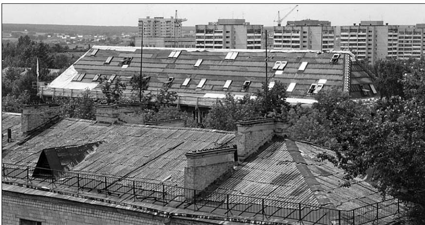
Рис. 3. На первом плане типовой нереконструированный дом серии 1-447, на втором плане – крыша дома после реконструкции
