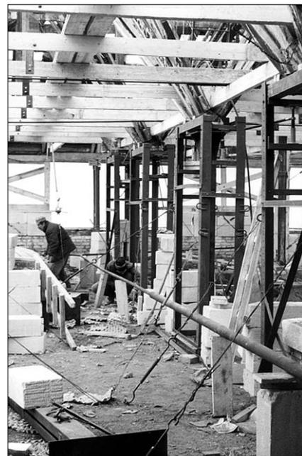
Рис. 6. После подъема крыши специальными домкратами, она опирается на металлические колонны
