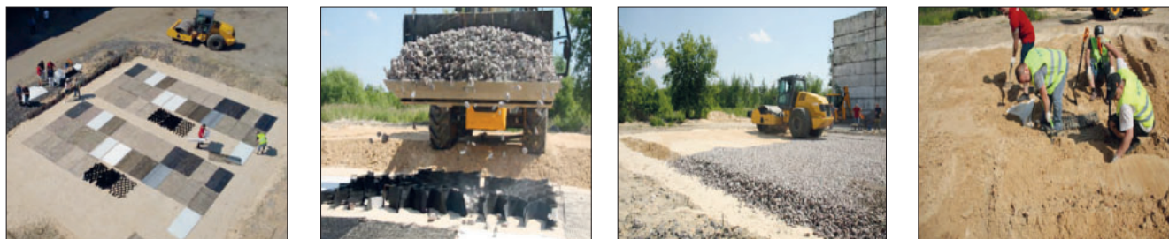
Рис. 2. Общий вид испытательного полигона с размещением геосинтетических материалов, засыпкой, уплотнением и извлечением Fig. 2. General view of the test site with geosynthetics placement, backfill, compaction and extraction
