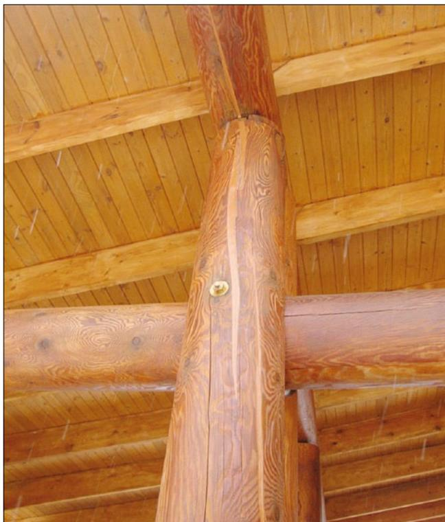
Рис. 5. Усушечные трещины, заполненные акриловым герметиком Acryl 100 фирмы Remmers (стойка и прогон внутри помещения)
