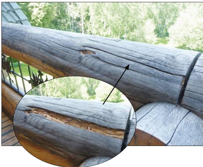
Рис. 2. Разрушение стенового бревна (балкон) в результате отсутствия конструктивной защиты от осадков
