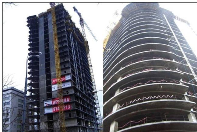
Рис. 1. Возведение 24-этажного здания корпорации Gaz-oil-trade с каркасом из монолитного керамзитобетона класса по прочности В45–В50, марки по плотности D1800–D1850 (Москва, ул. Наметкина, д. 12, 2006 г.)
