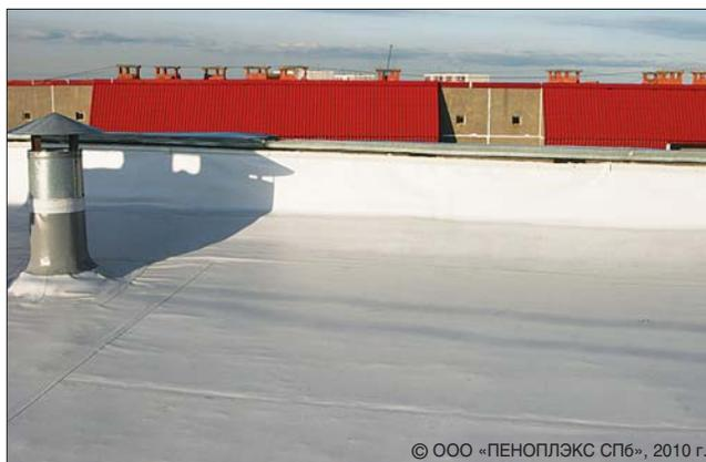
**Рис. 4.** Реконструкция старой битумной кровли без утепления, г. Гатчина Ленинградской обл. Материал ПЛАСТФОИЛ®
