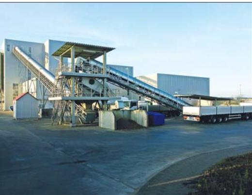
На станции просеивания происходит отделение крупной фракции, непригодной для производства. Далее песок при помощи транспортеров подается на промежуточное складирование над смесительной установкой
