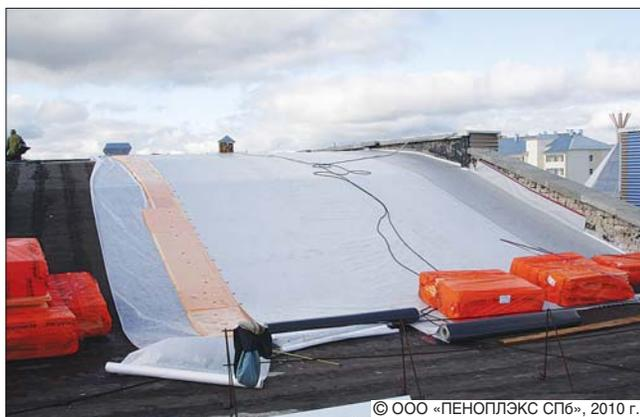
**Рис. 3.** Реконструкция старой битумной кровли с дополнительным утеплением, г. Нарьян-Мар. Материалы ПЛАСТФОИЛ®, ПЕНОПЛЭКС®
