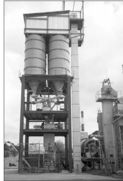
Рис. 7. Центральная секция небольшого завода
