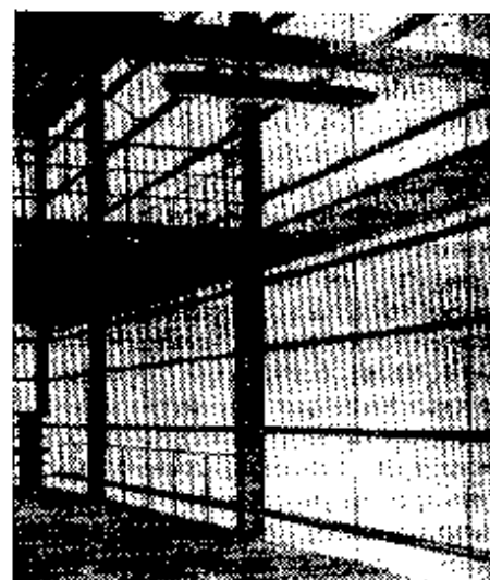
Рис. 7. Витраж производственного здания, выполненный с использованием профилированных коробчатых элементов фирмы «Хелста» из материала «хосталит бет» (ФРГ)
