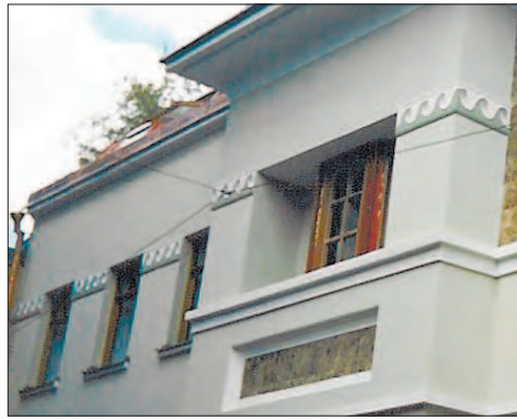
Рис. 1. Элементы гипсового декора на фасадах зданий
