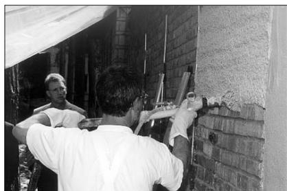
Оштукатуривание поверхности проводилось с помощью штукатурного агрегата
