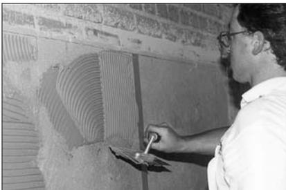
Плиточный клей наносят на специально подготовленную поверхность зубчатым шпателем
