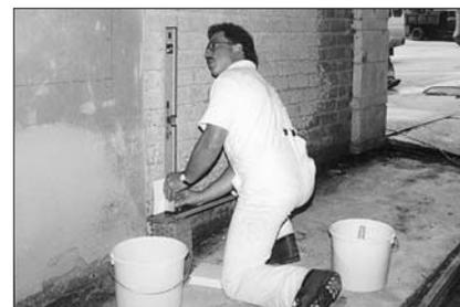
При укладке плитки по толстослойной технологии использование уровня является одним из основных условий получения ровной поверхности
