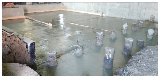
Рис. 2. Фрагмент выпусков буроналивных свай ЭРТ Fig. 2. Fragment of releases of EDT bored injection piles
