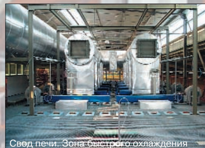
Свод печи. Зона быстрого охлаждения
