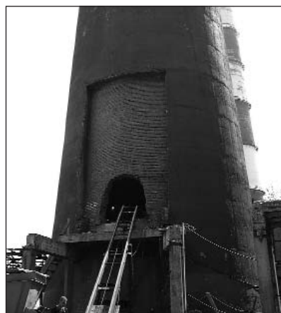
Рис. 1. Внешний вид трубы при проведении ремонтных работ
