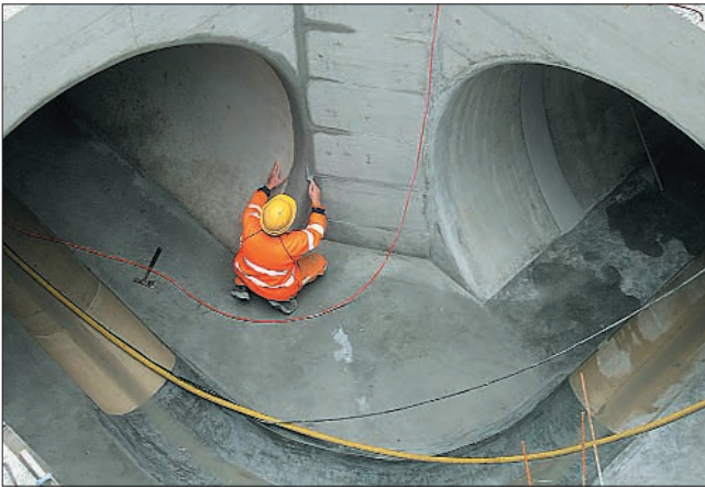
Ремонт коллектора составами Sika Repair®
