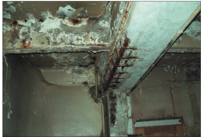
Дефект бетонной поверхности, нуждающийся в ремонте
