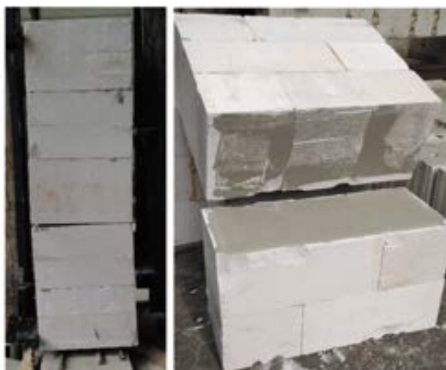
Рис. 3. Характер разрушения каменной кладки на полимерцементных швах по неперевязанному сечению
