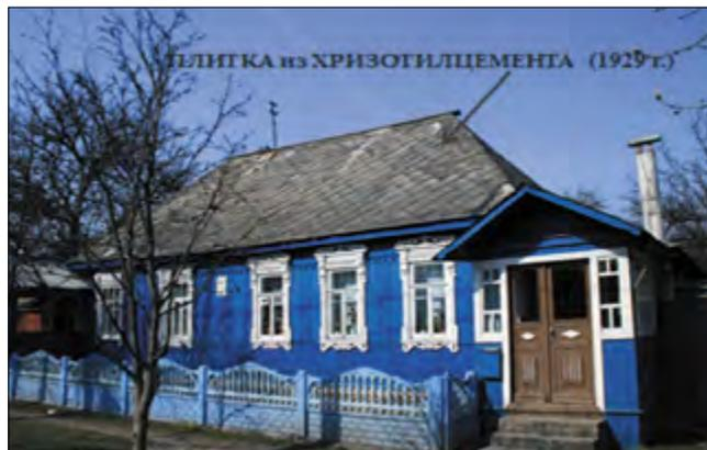
**Рис. 2.** Первые хризотилцементные кровельные плитки, установленные на кровлю в Брянске в 1929 г.
