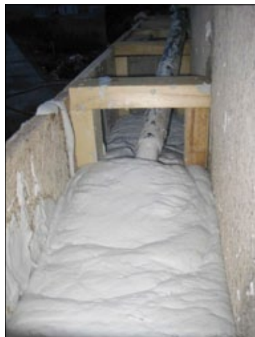
Рис. 1. Процесс заливки пеногипса в несъемную опалубку
