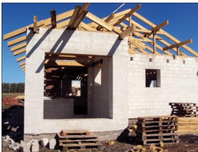
Рис. 7. Возведение жилого дома
