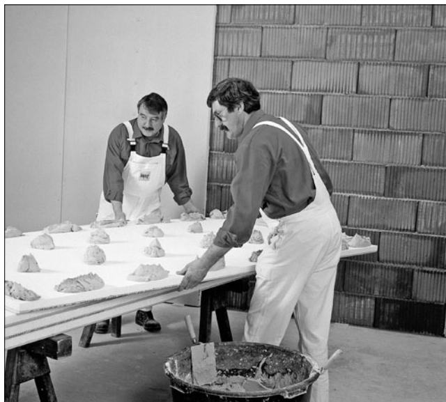
Рис. 2. Монтаж многослойной гипсокартонной оболочки
