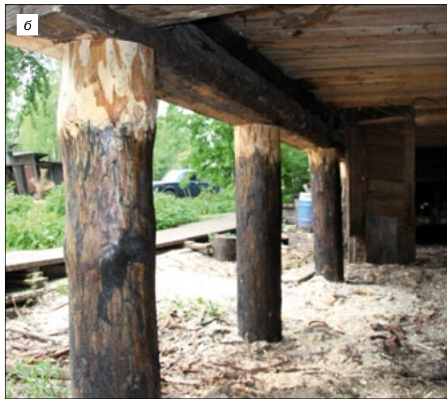
Рис. 1. Эксплуатируемые деревянные фундаментные стойки до ремонта (а) и после замены (б)
