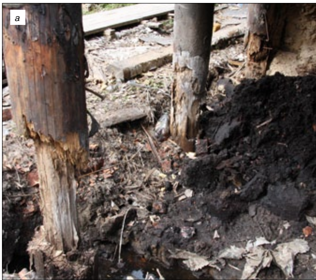
Рис. 1. Эксплуатируемые деревянные фундаментные стойки до ремонта (а) и после замены (б)
