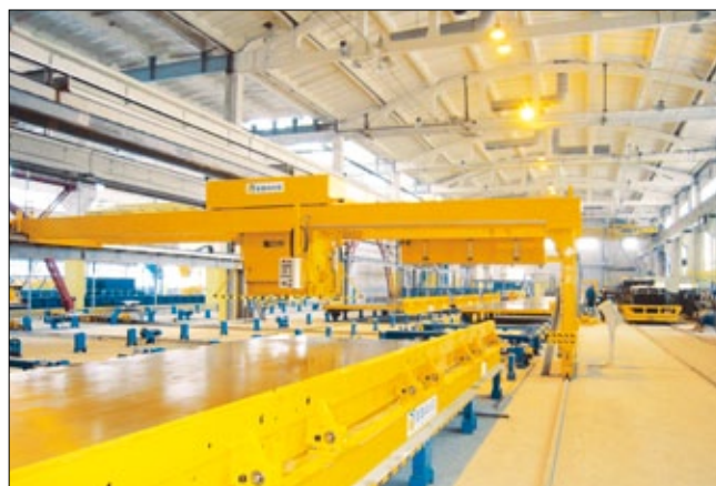
Вид на новый производственный цех завода РУП «Могилевский ДСК» (Могилев, Республика Беларусь)
