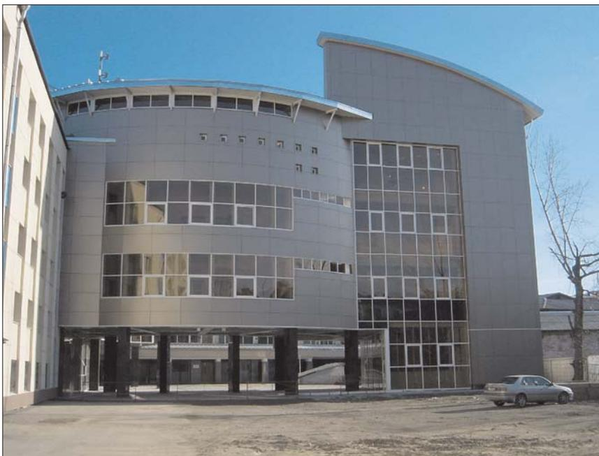
ная скорость потока воздуха на поверхности твердого тела равна 0. Из такой конструкции ни ветер, ни восходящий поток воздуха в воздушной прослойке не вынесет ни тепло, ни сам утеплитель.
