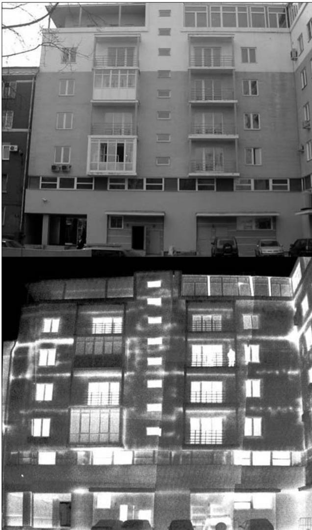
**Рис. 4.** Фотография и термограмма части фасада монолитного жилого здания с трехслойными стенами: штукатурка – 20 мм; кирпич полнотелый М100 – 240 мм; утеплитель ПСБ-С М25 – 150 мм; кирпич полнотелый М100 – 120 мм; штукатурка – 30 мм. Дополнительными источниками теплопотерь являются межэтажные перекрытия.  $R_{\text{факт}} = 2,1 \text{ м}^2 \cdot \text{°C}/\text{Вт}$  ( $\pm 15\%$ )
