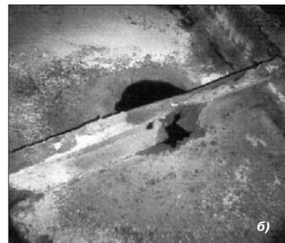
Рис. 1. Разрушение строительных конструкций в цехе по производству азотных удобрений под действием азотной кислоты и ее паров: а – железобетонных конструкций; б – металлических конструкций
