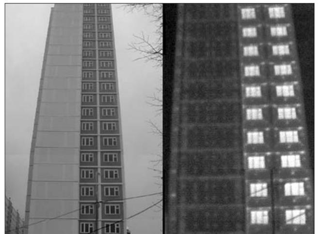
**Рис. 6.** Фотография и термограмма части фасада панельного жилого здания серии КОПЭ с трехслойными панелями: наружный слой панели из пластического бетона – 60 мм, внутренний – из жесткого бетона – 70 мм, слой ПСБ-25 – 120 мм. Дополнительными источниками теплопотерь являются дискретные связи (шпонки), вертикальные и горизонтальные межпанельные соединения, особенно в местах расположения крепежных элементов.  $R_{\text{факт}} = 2,7 \text{ м}^2 \cdot \text{°C}/\text{Вт}$  ( $\pm 15\%$ )
