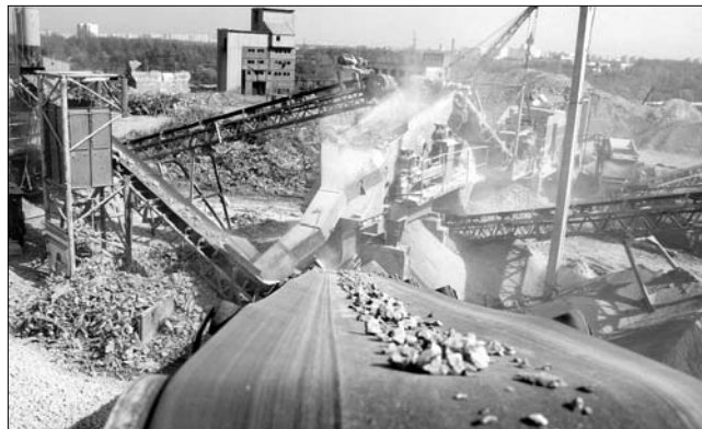
На производственной площадке фирмы «Сатори» (Москва) отходы превращаются в доходы
